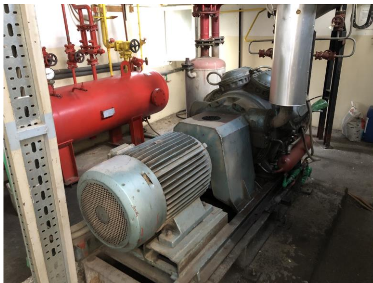
Слика 4.32 Расхладно амонијачно постројење
