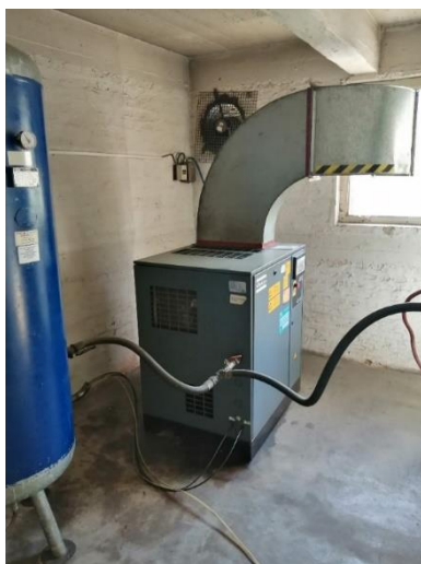
Слика 4.35 а) Ваздушни компресор Atlas Copco GA15 FF
